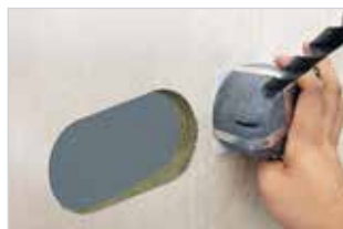
3. Conduit / Cable Penetration Cutting
